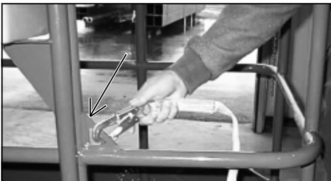
Figura 6: Punto de anclaje típico del arnés de seguridad
